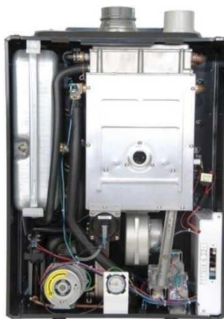
Рисунок 2.5 - Общий вид и внутреннее строение котла Daewoo 400VSC
